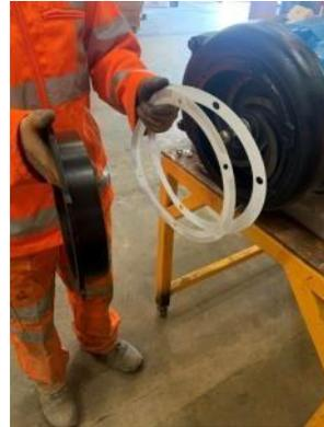
**7.** Retire la tuerca de la tapa del eje y la tuerca de retención del impulsor, junto con la tapa del saliente del impulsor.
